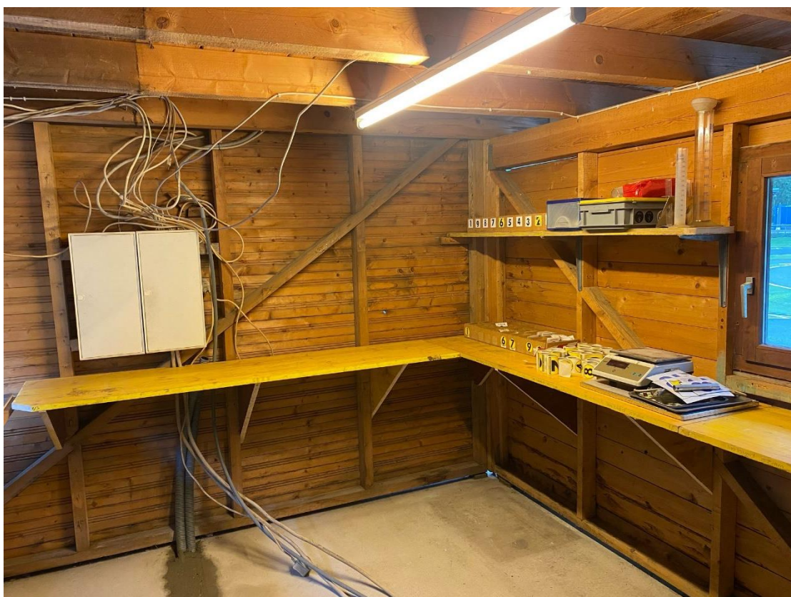
QUADRO ELETTRICO RIPOSIZIONATO / NEU AUFGESTELLTE SCHALTAFEL
