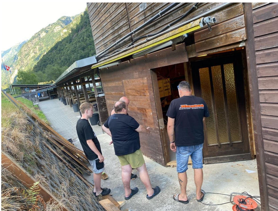
PARETE LATO AUTOSTRADA NELLA NUOVA POSIZIONE / MAUER AN DER AUTOBAHNSEITE IN NEUER POSITION
