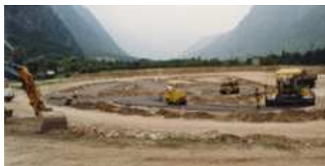
Primi tratti in asfalto: siamo in agosto!
